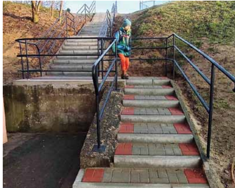
Schody przy SP1
